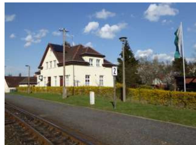
Wenige Schritte vom Gartentor entfernt geht es zu den Zügen. Von zwei Bahnsteigen fahren die Züge nach den Gebirgsorten Oybin und Jonsdorf sowie nach der nahen Kreisstadt Zittau ab, ein „Begegnungsbahnhof“.
